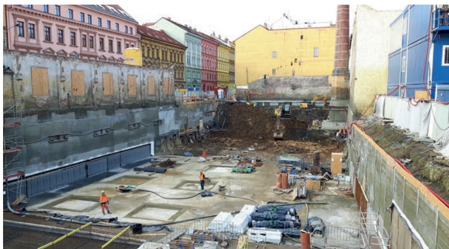
Dokončovací práce na stavební jámě s definitivní úrovní výkopu zasahující 1 až 2 m pod hladinu podzemní vody.
