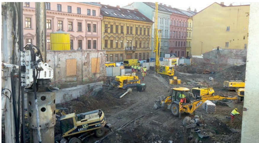
Souběh několika činností při realizaci stavební jámy a hlubinného založení objektu vyžadoval vysoké nároky na koordinaci prací ze strany vedení stavby.
